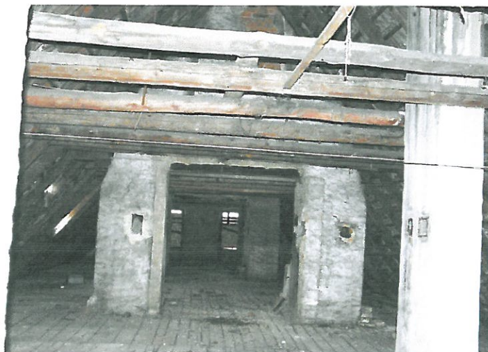
Fot. 7 Konstrukcja dachu, kominy
